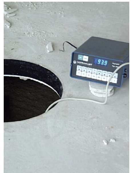
(11) Feuchtemessung in einem Bodenhohlraum
