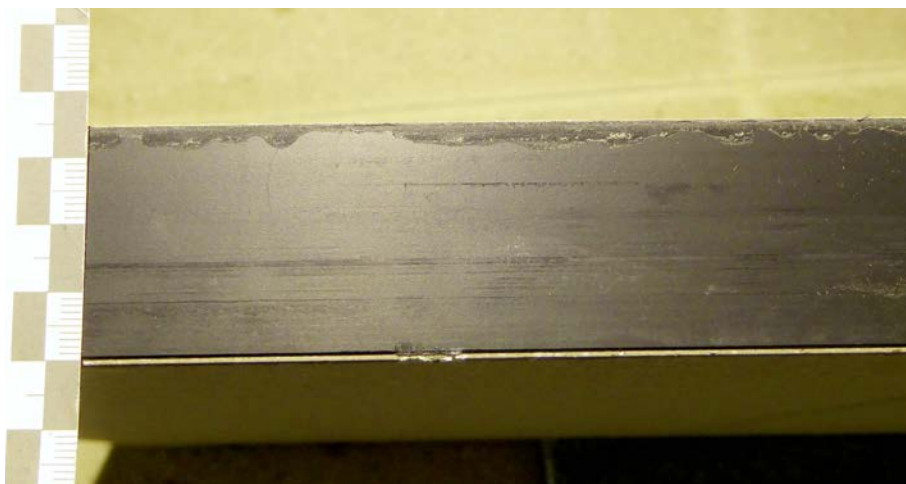
(14) Beispiel einer Plattenkante mit Überbeschichtung durch Grundierung
