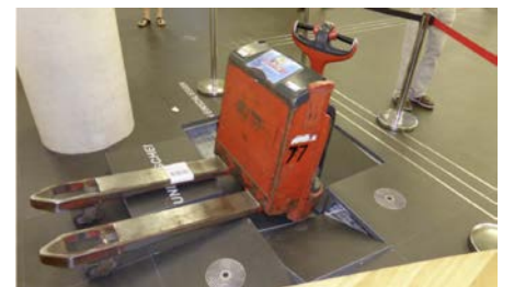
(5) Überbelastung durch einen Elektrohubwagen
